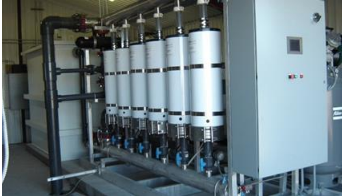
Figur 7-2 Eksempel på UF-system (Lenntech)
