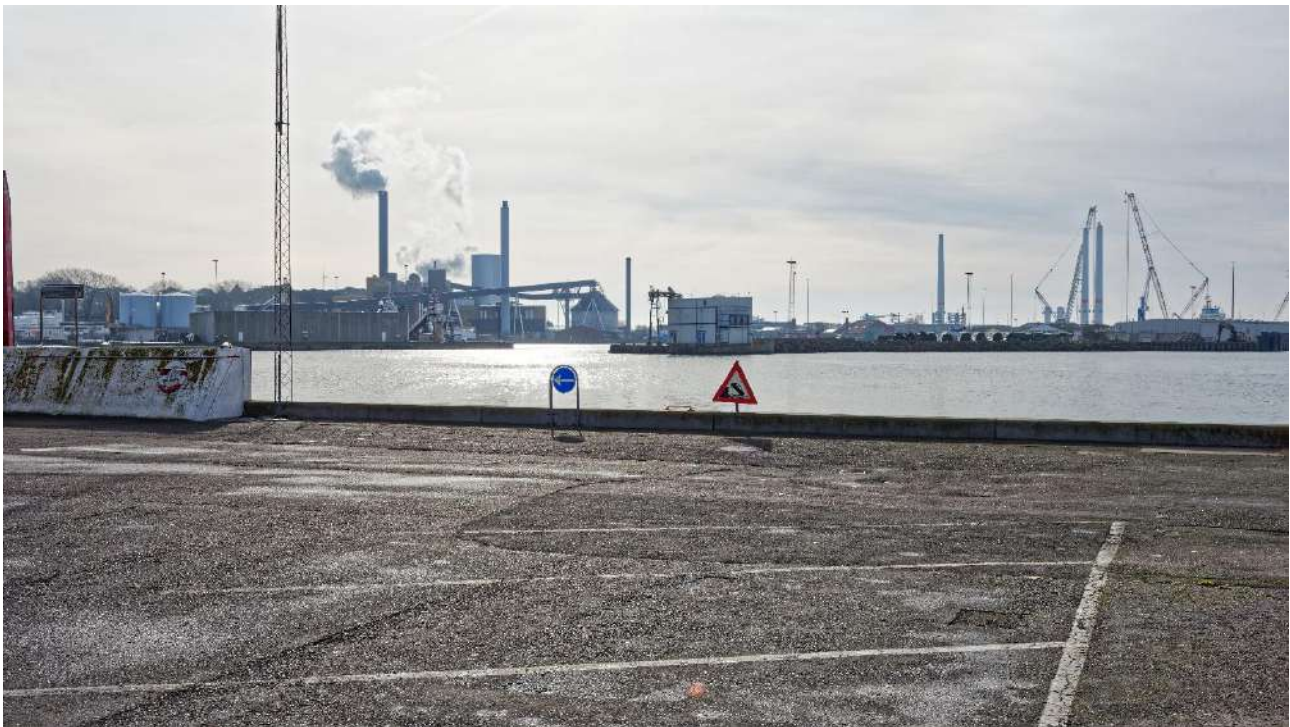
Figur 13.20: Standpunkt 3. Eksisterende forhold. (Foto: NIRAS A/S)
