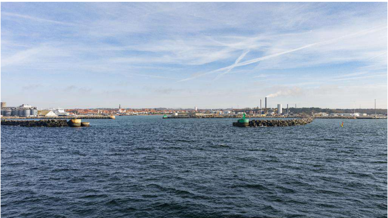
Figur 2.3: Standpunkt 1. Eksisterende forhold. (Foto: NIRAS A/S)
