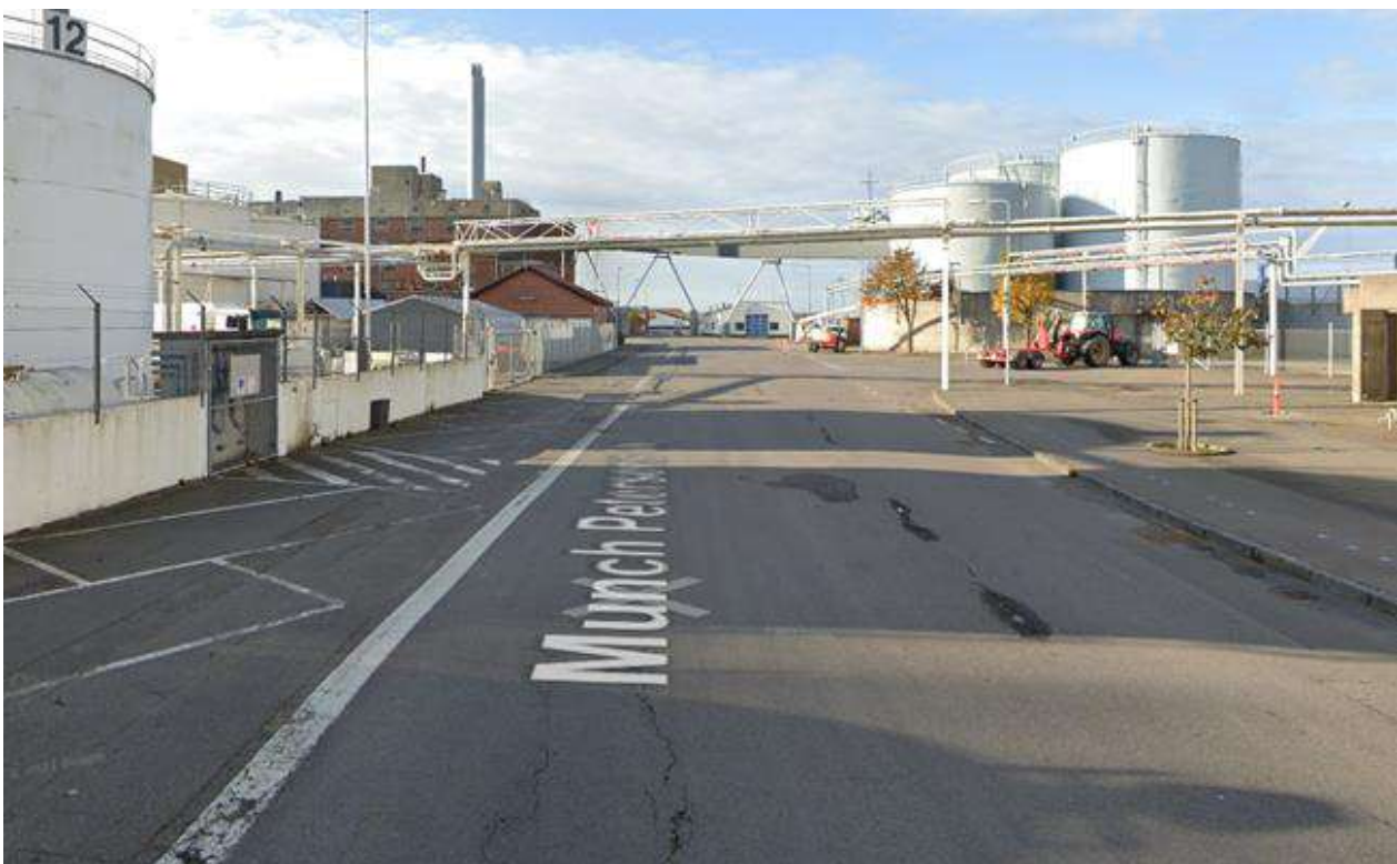
Figur 14.6 Munch Petersens Vej set mod sydvest. Over vejen ses rørledningen (Google streetview).
