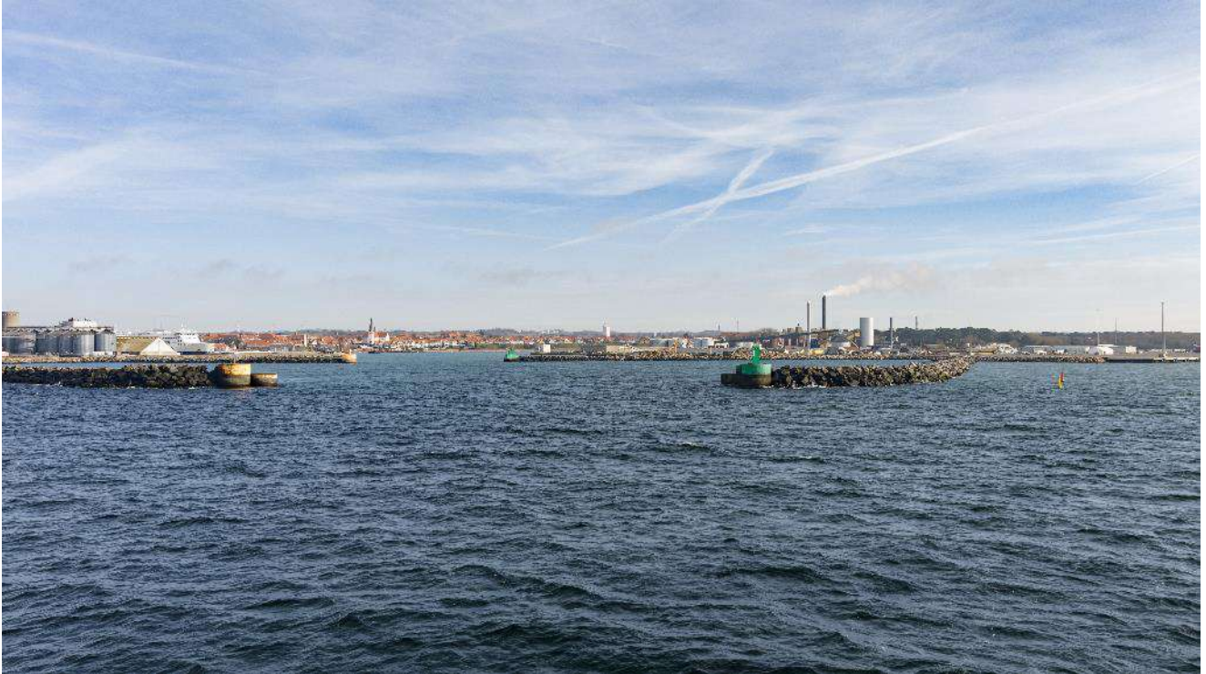
Figur 13.10: Standpunkt 1. Eksisterende forhold. (Foto: NIRAS A/S)
