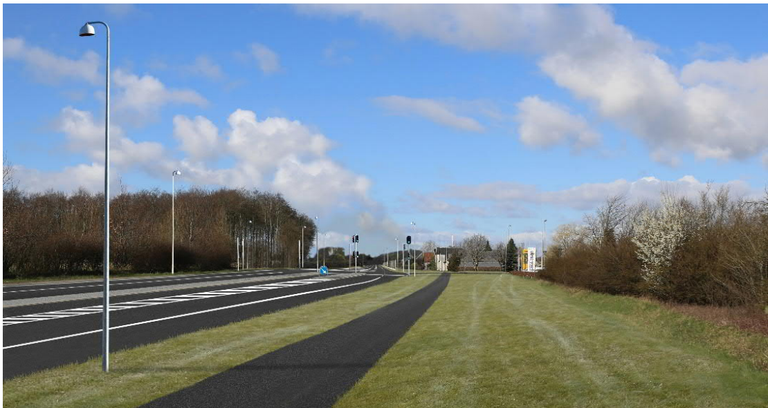
Figur 7.7 Skov, signalanlæg og støjskærm 2+2 løsning
