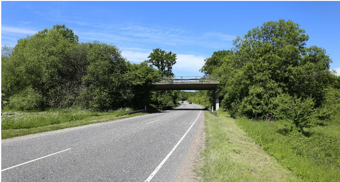
Figur 7.12 Bangsebrovej – eksisterende bro
