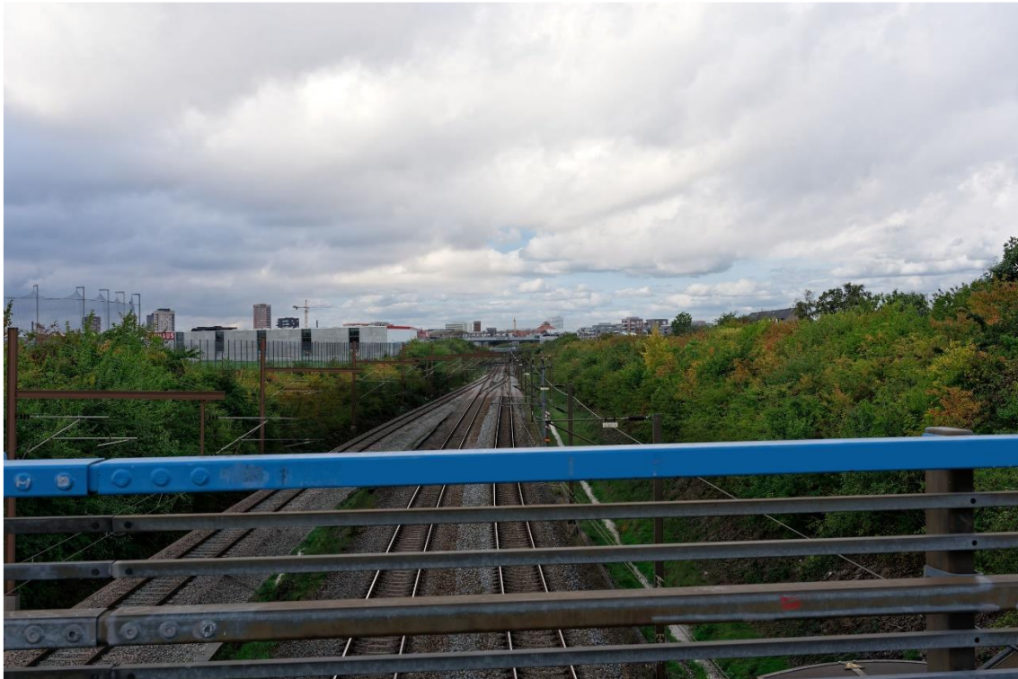
Figur 1: Visualisering mod vest (kig mod Valby) af overhalingsspor ved Kalvebod, hvor det ses, at et nyt spor er etableret til venstre. Det nye spor kan anvendes af gennemkørende tog mod øst, mens sporet "i midten" kan anvendes af holdende godstog som kan overhales i begge køreretninger.
