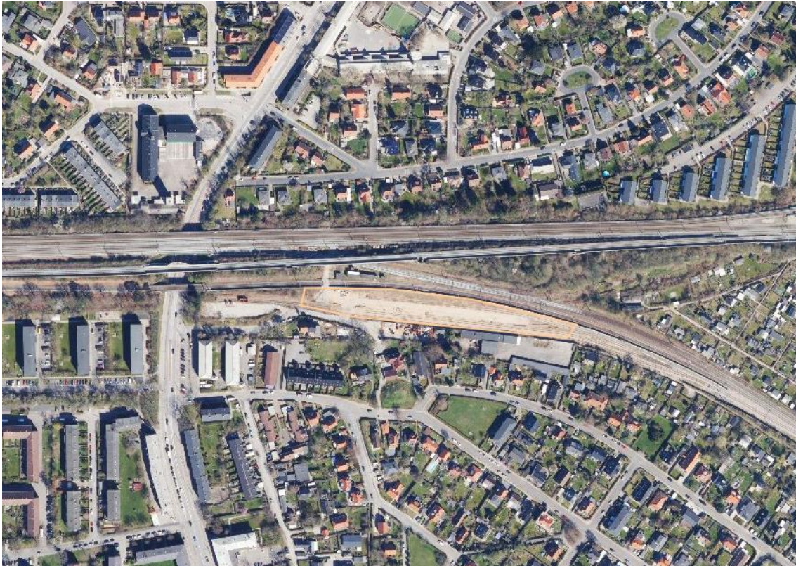
Figur 4: Oplags- og læsseplads for banetekniske komponenter ved Vigerslev Godsvej
