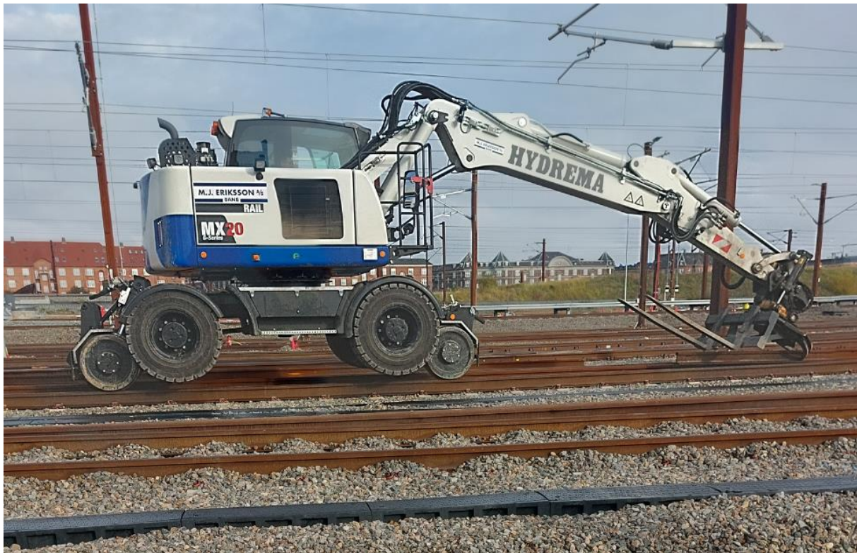
Figur 2: Billeder fra testopstilling hvor gravemaskine trækker skinne.
