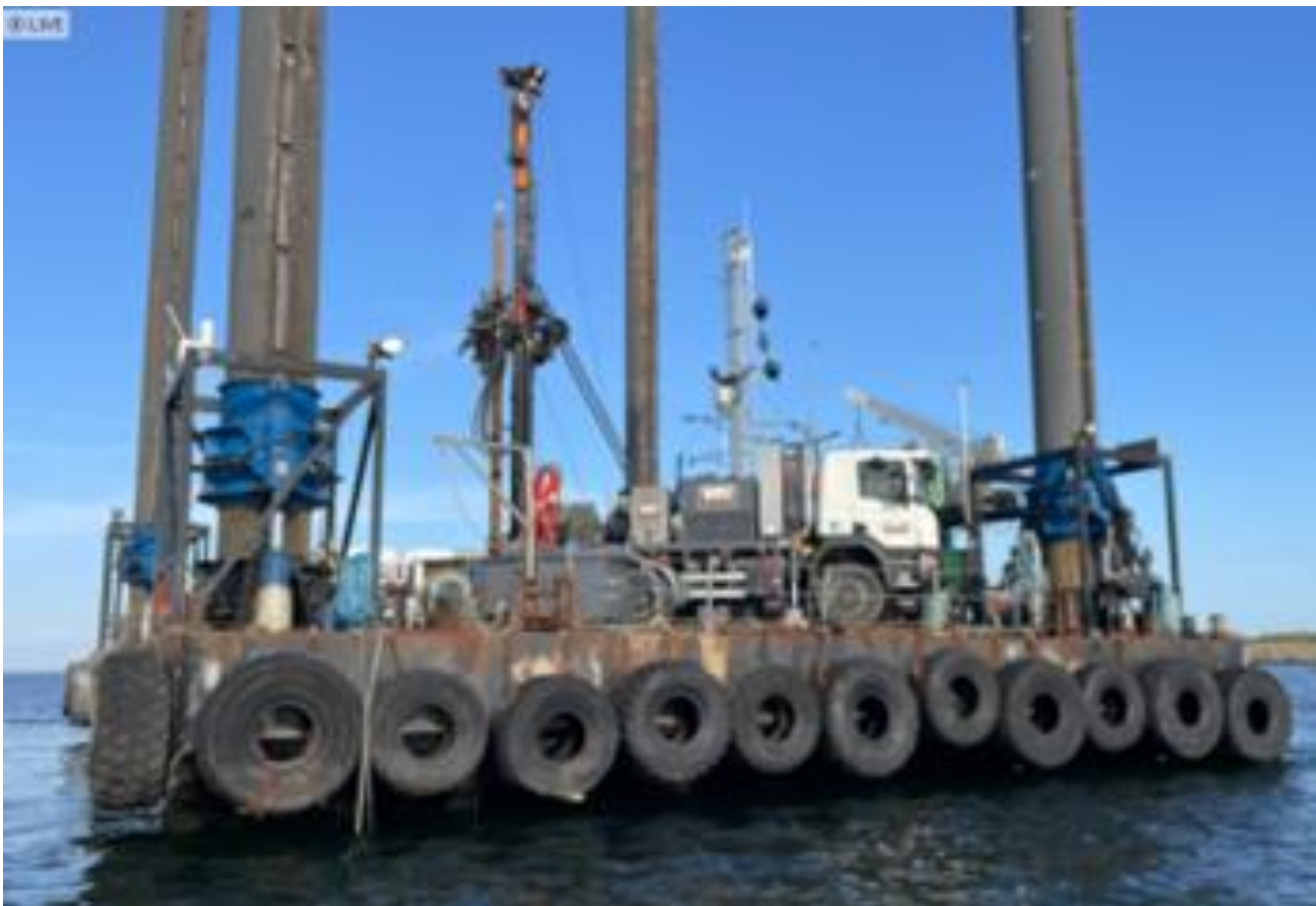
Figur 2: Geoteknisk boring fra Jack-up pram. Prammen 4 ben sættes på havbunden, hvorefter prammen hæves op så den står stabilt, upåvirket af bølger og strøm. Boreværk monteret på lastbil midt i billedet. Ud over boreværket er prammen udstyret med containers til vandrensning, mand-skabsskure, strømforsyning mv. Københavns Nordhavn august 2023.
