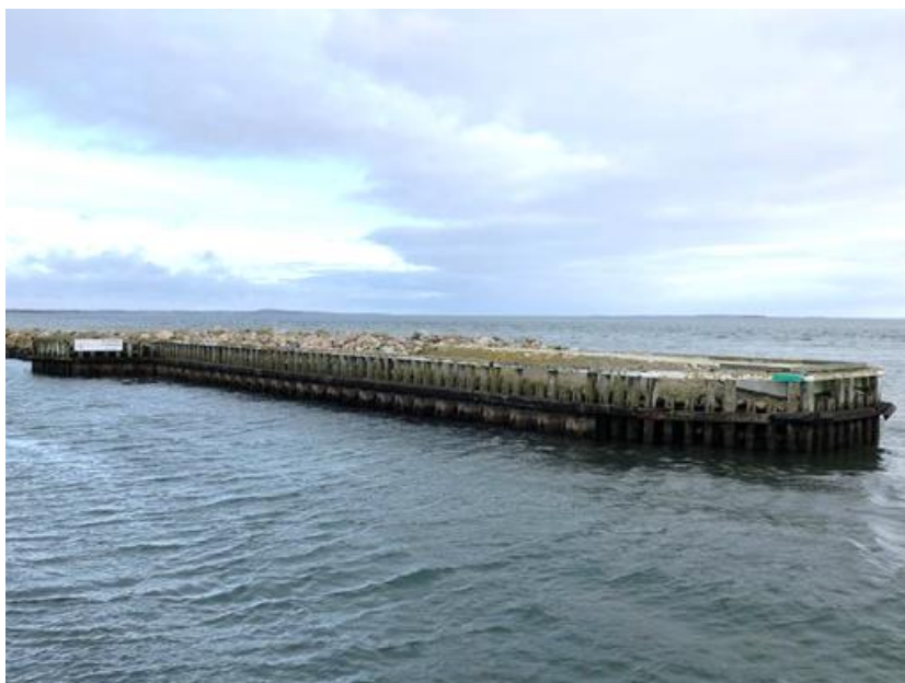
Figur 2 – Molehoved med begrænset restlevetid langs østlig side af indsejlingen til Årø Sund Havn
