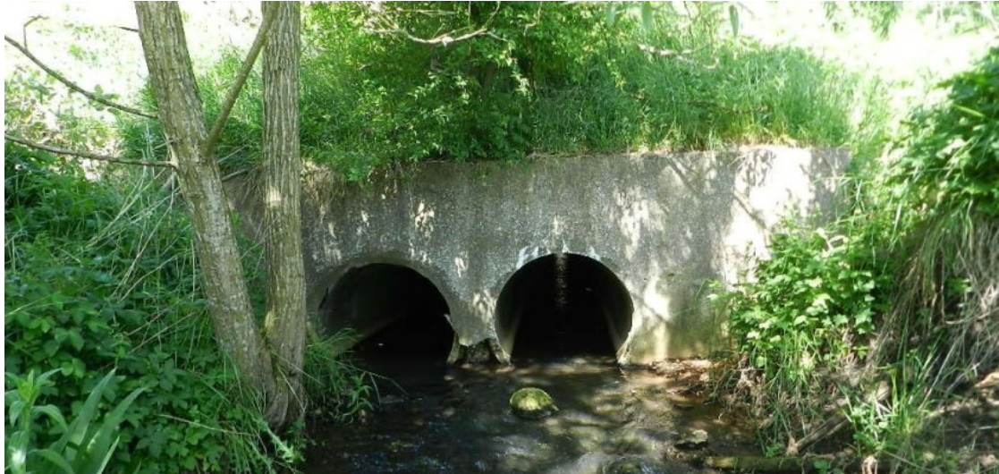
Figur 1-2 Eksisterende rørunderføring af Krudals Å. Fungerer ikke som faunapassage.
