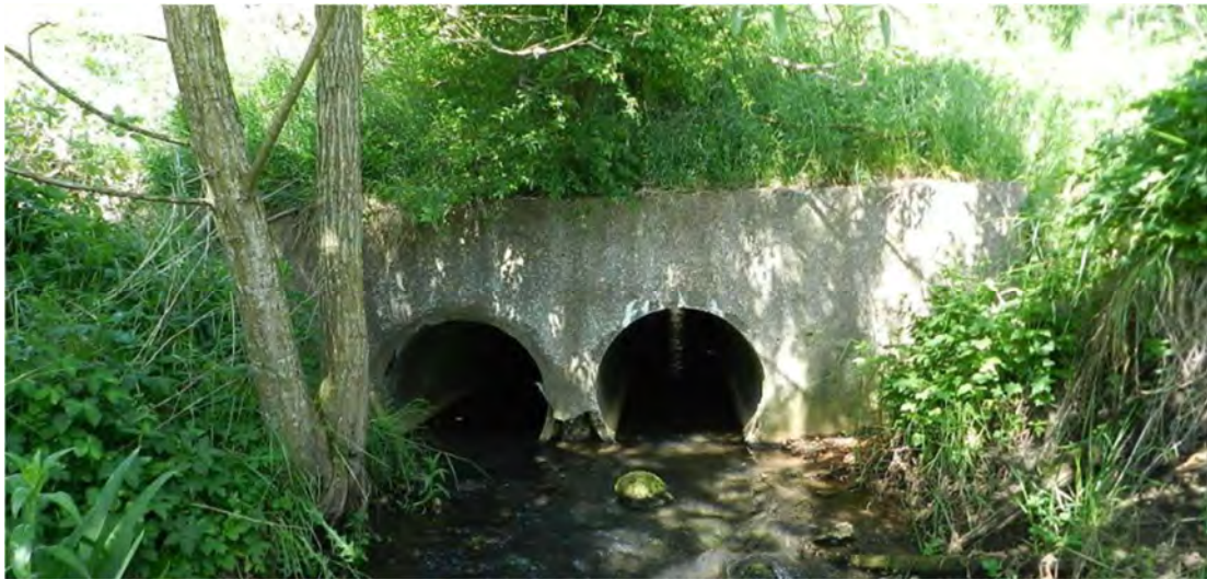
Figur 3.6 Eksisterende underføring af Krudals Å.
