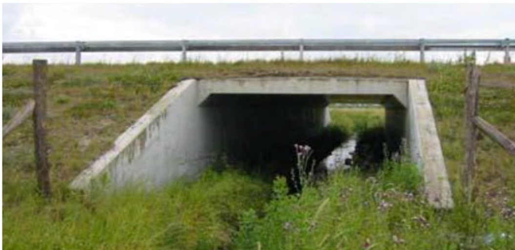
Figur 17.10 Eksempel på en B1 faunapassage udført som elementtunnel
