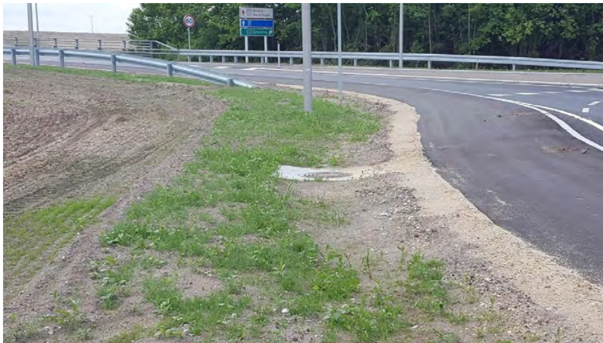
Figur 3.2 Eksempel på et afvandingstrug
