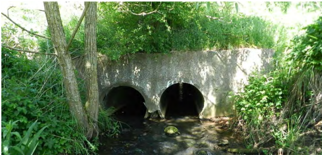
Figur 17.9 Eksisterende underføring af Krudals Å.
