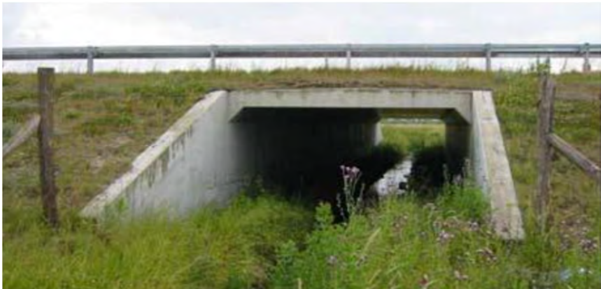
Figur 4.18 Eksempel på en B1 faunapassage udført som elementtunnel
