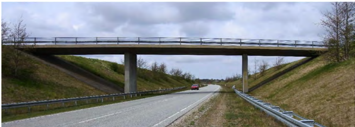
Figur 4.27 Eksempel på en 3 fags åben pladebro.
