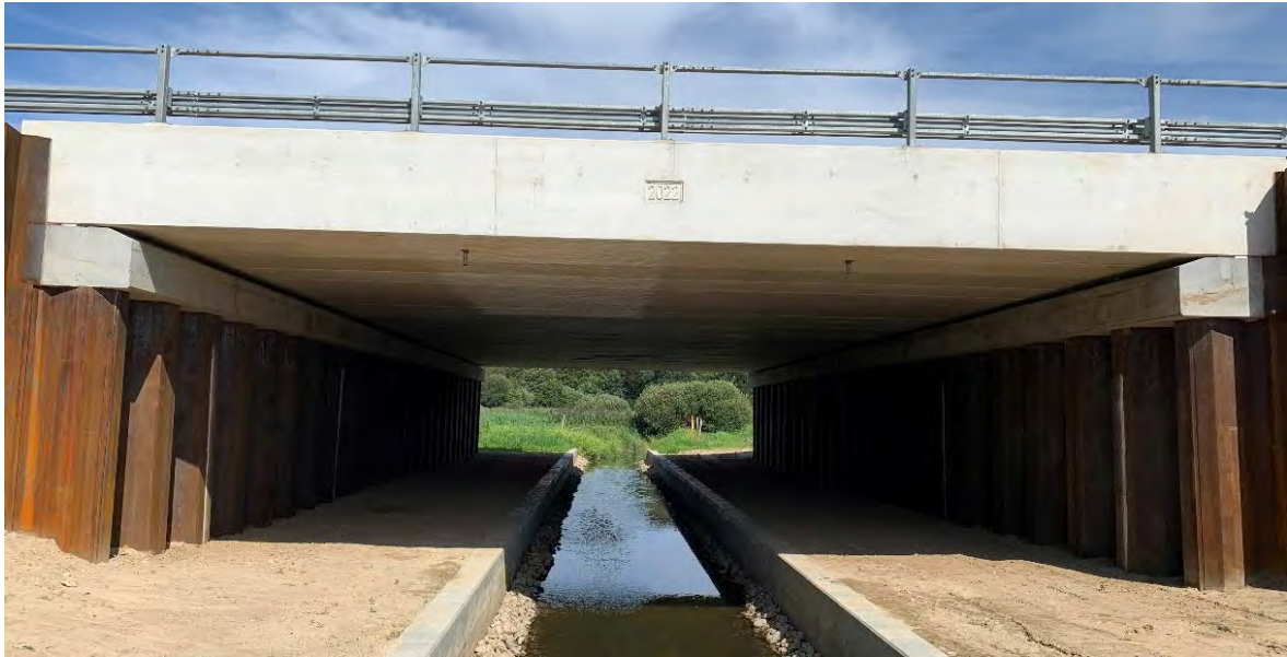
Figur 4.17 Eksempel på en faunapassage med nedrammede spuns vægge og betondæk
