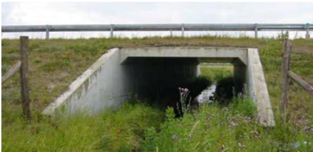
Figur 3.7 Eksempel på en B1 faunapassage udført som elementtunnel
