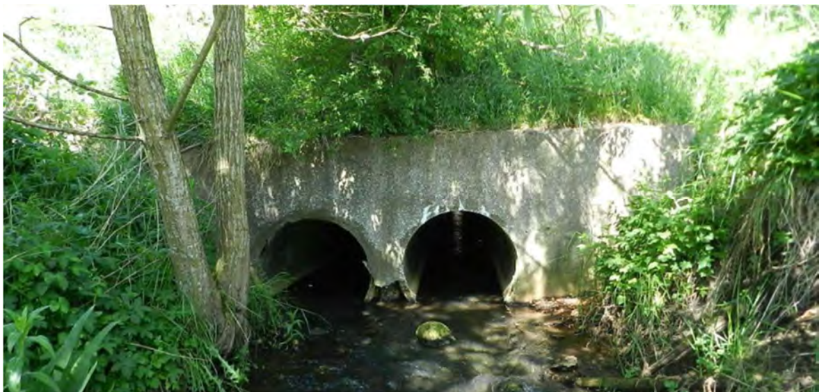
Figur 4.16 Eksisterende underføring af Krudals Å.
