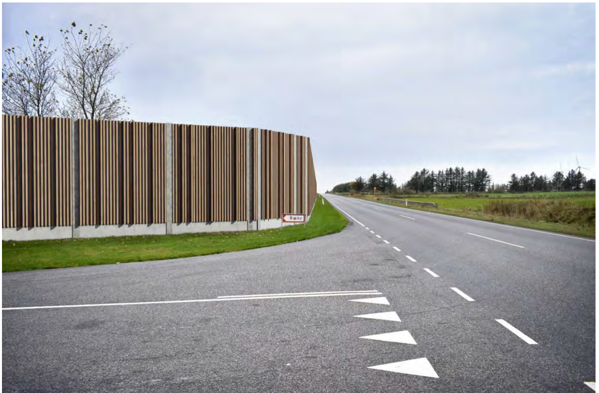
Figur 8.23 Støjskærmen ved Røhr, før og efter. Som visualiseringen viser, vil støjskærmen have en indvirkning på landskabet lokalt, men i det store billede være uden betydning, idet den kun forløber på en kort strækning.
