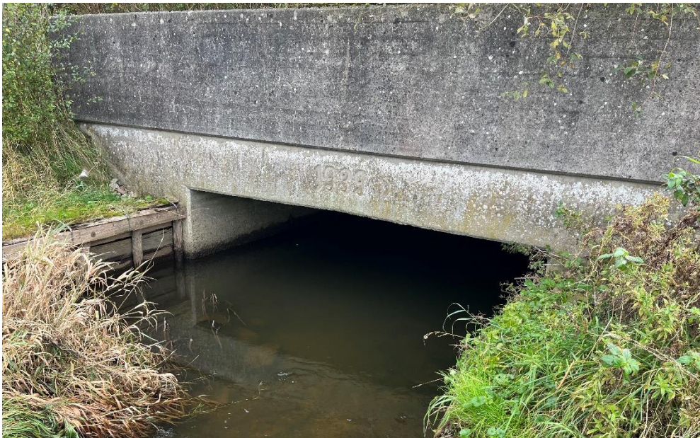
Figur 3-15: eksempel på konstruktionen af det undergående vandløb, på strækningen mellem Jels og Øster Lindet.
