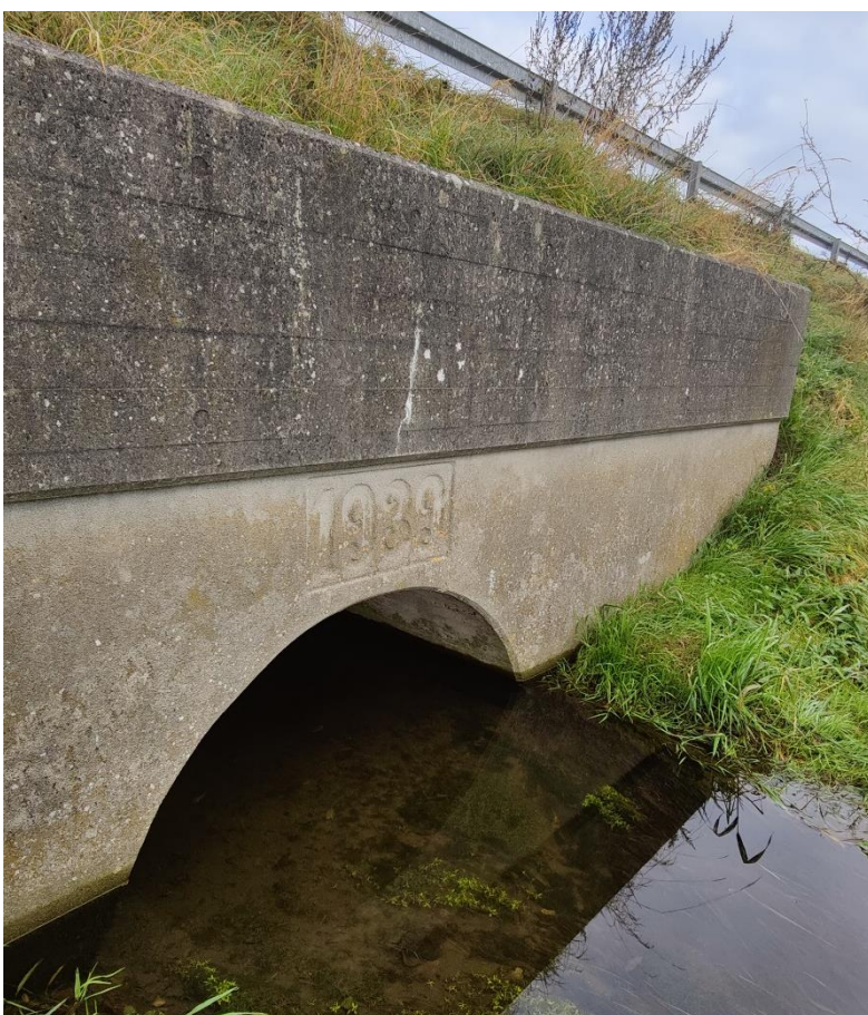
Figur 3-14: eksempel på konstruktionen af det undergående vandløb, på strækningen mellem Jels og Øster Lindet.
