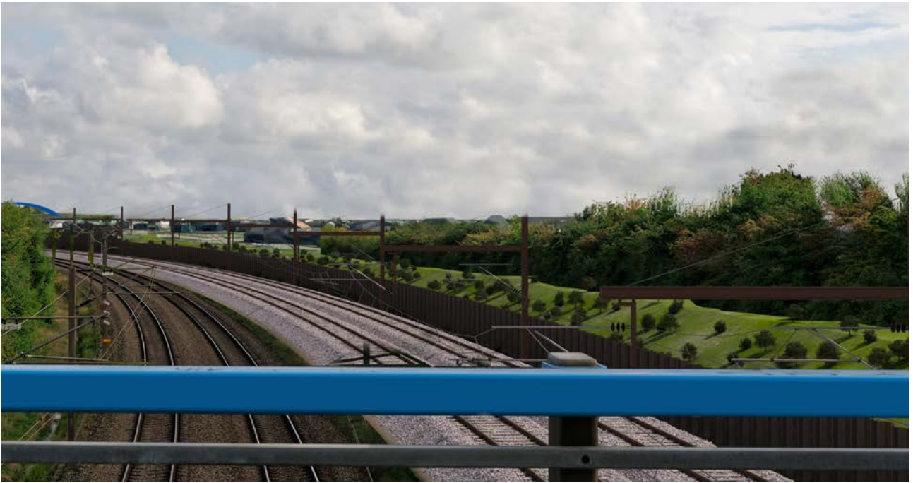
Visualisering af, hvordan det kommer til at se ud med to nye overhalingsspor. Her ses også støttevæggen og volden, som den vil se ud, inden beplantningen er tilvokset.
