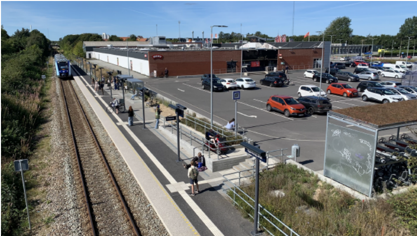
Billede: Nyt standsningssted for togene i Hjørring Øst samt anden forbedring for den kollektive transport
