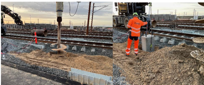
Figur 4.2.2 Etablering af mastefundamenter
