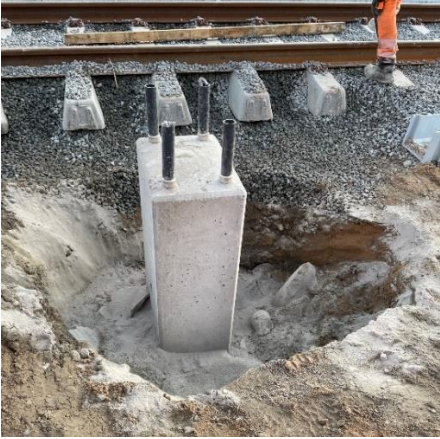
Figur 4.3.2 Etablering af mastefundament
