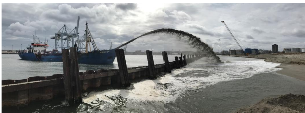
Figur 4-7 Indpumpning af sand ved 'rainbowing' ifm. etablering af 1. fase af Omnikajen.
