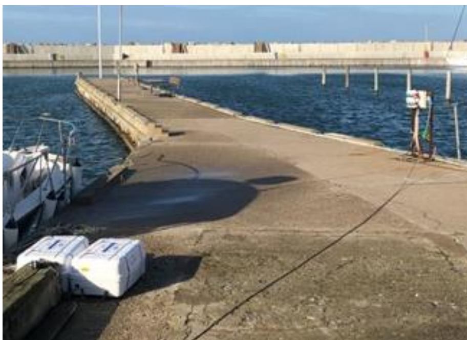
Figur 3 – Den gamle stenkiste. Pælene i stenkisten er stærkt angrebet af pæleorm og ved inspektionen var ca. 50 % af pælediameteren væk. Derudover er flere pæle knækket og ikke i kontakt med havbunden.
