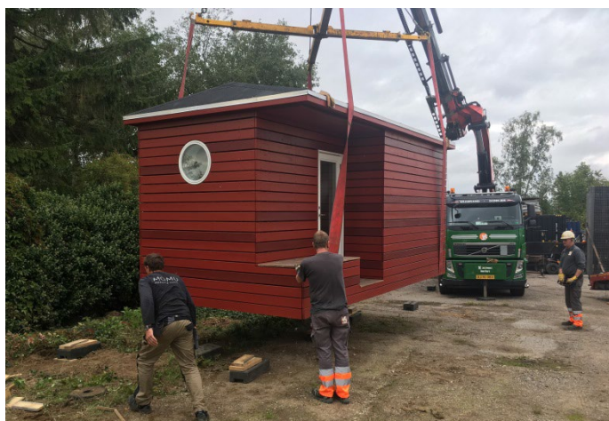
Figur 1. En af de fire ny boliger udført på Sjælland sættes her på plads på Sylbækvej. Foto: Kim Kromann.
