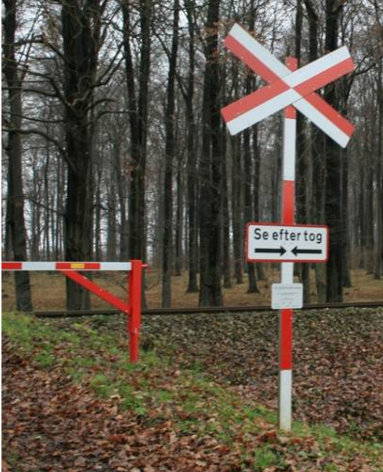
En usikret overkørsel (sti) med krydsmærke og manuel bom.
