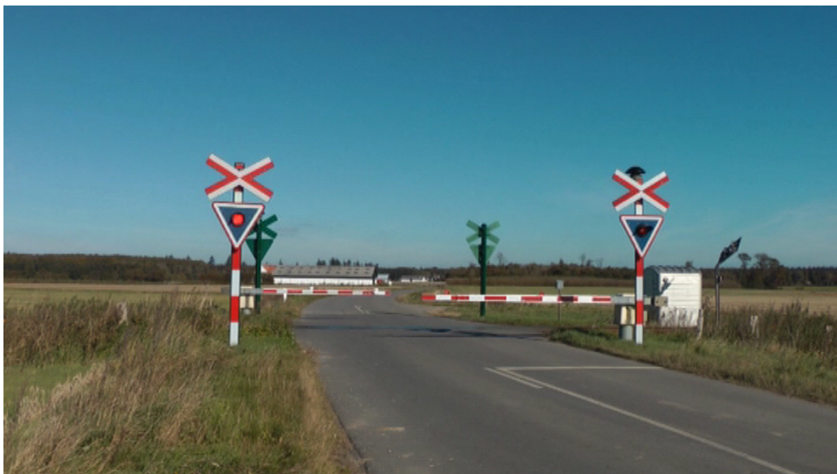
En overkørsel med et spor sikret med et halvbomanlæg.
