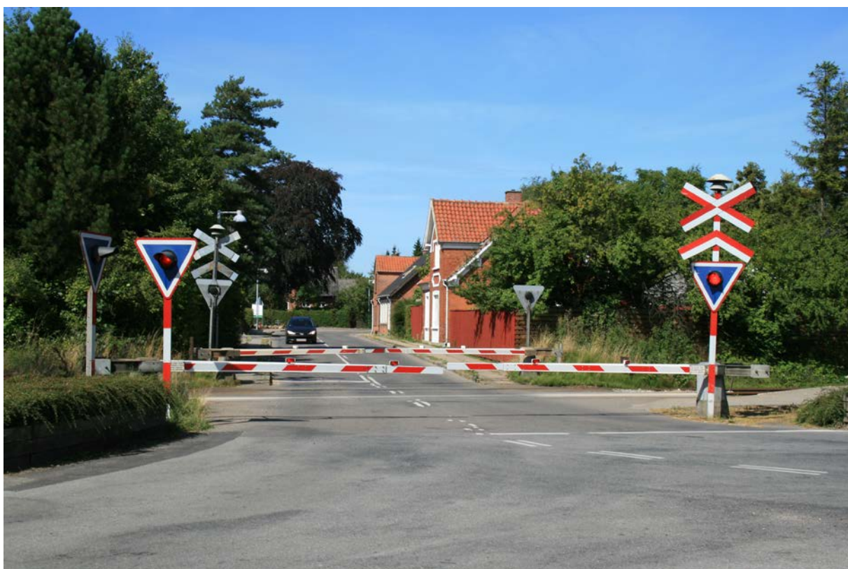
En overkørsel med flere spor (her 2) sikret med et helbomanlæg.
